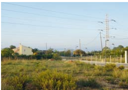
Línies d'alta tensió que travessen els dotacionals públics en la Zona Sud
