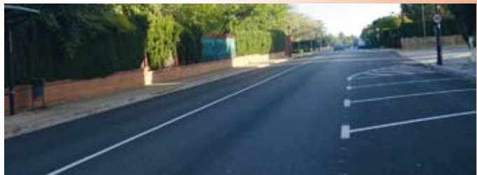
Asfaltat de l'òval de Mas Camarena
