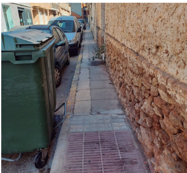
Voreres estretes Carrer Teodor Llorente
