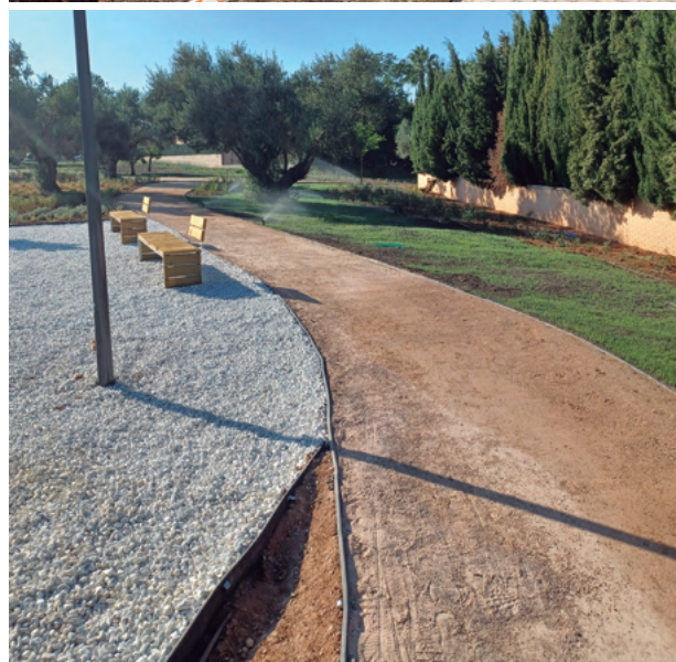
Obres en "PARQUE NORTE". Jardí ja executat
