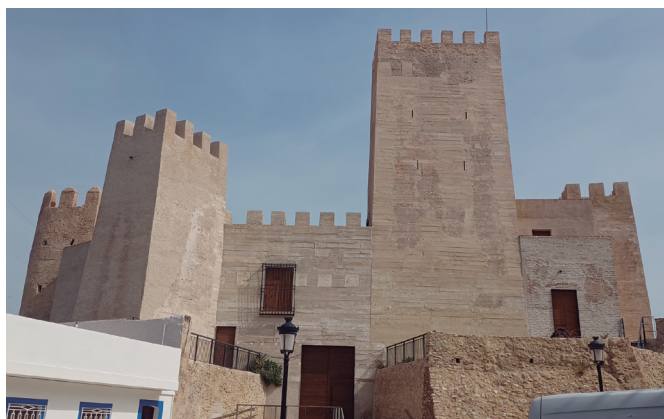
Restauració del Castell de Bétera amb fons FEDER, un projecte de Compromís
