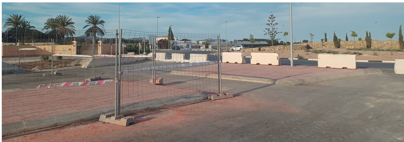
Variant Nord a punt de finalitzar-se el segon tram. Un projecte de Compromís
