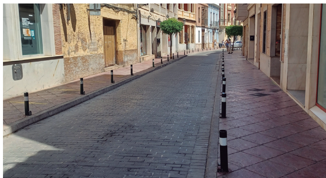
Remodelació i millora urgent del carrer Alfàbegues, el punt més comercial de Bétera i punt neuràlgic de les festes locals, que està en un estat deplorable
